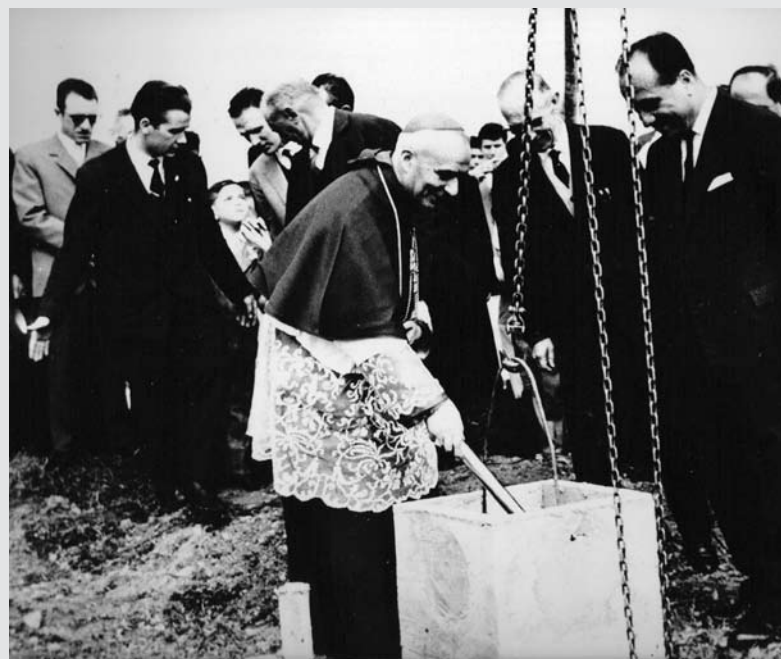
1960 - Posa della prima pietra per la costruzione della Cartiera Cariolaro con la presenza del Vescovo Mons. Zinato.
