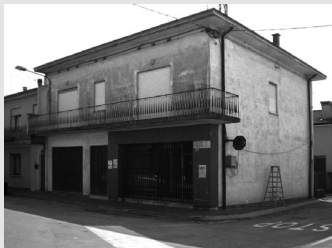
Una vista del negozio di via Tasca attualmente in fase di ristrutturazione.
