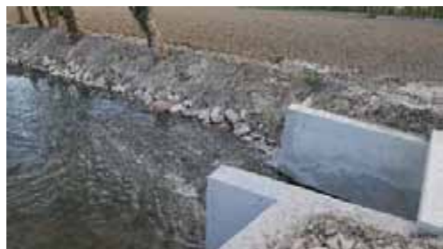
Foto 9 Cementificazione di una chiusa d'irrigazione "Bojo de mezzo"
