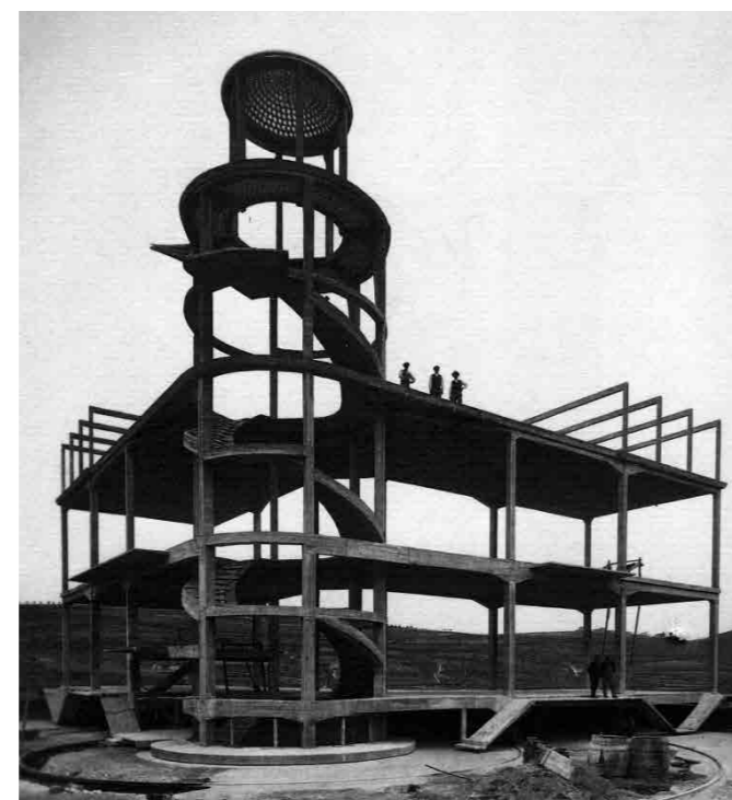
Durante la costruzione
