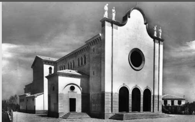
La Chiesa di Villalta appena costruita.
