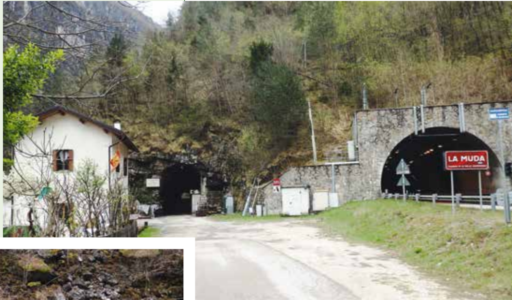
La Muda a sinistra ex casello ferroviario, al centro galleria ferroviaria a destra la nuova galleria SR 203
