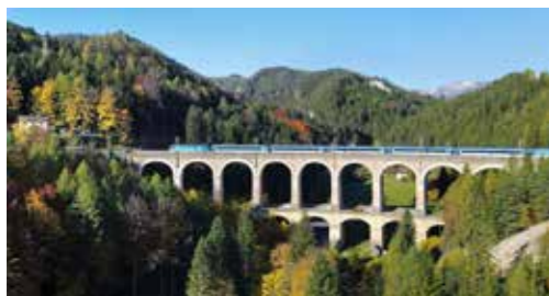
Il viadotto sulla Kalte Rinne, con le sue eleganti doppie arcate, rievoca le maestose opere dell'antica Roma, riportando alla mente la grandezza dell'ingegneria classica.
