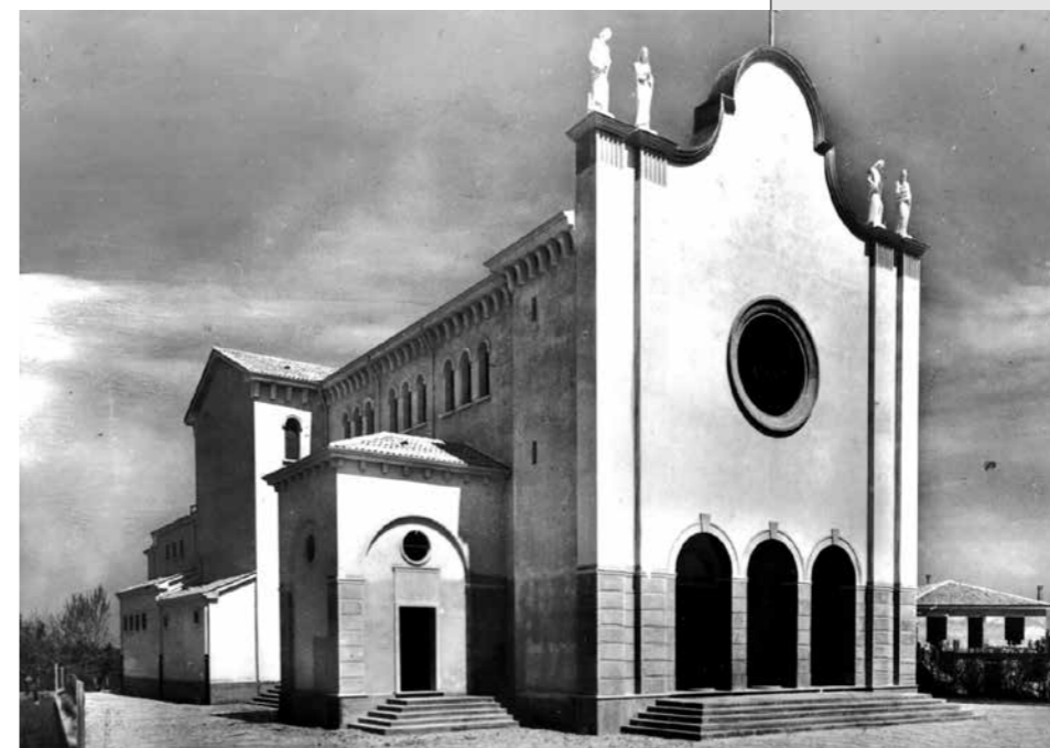
Esterni della nuova chiesa appena costruita.
